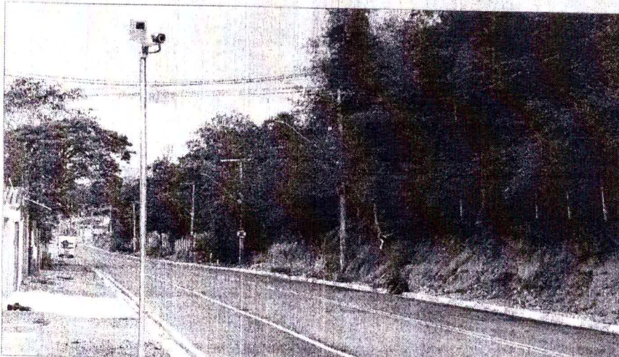
Nesta semana, a via recebeu dois radares e a Secretaria de Obras e Viação descartou a instalação de lombadas, por enquanto
